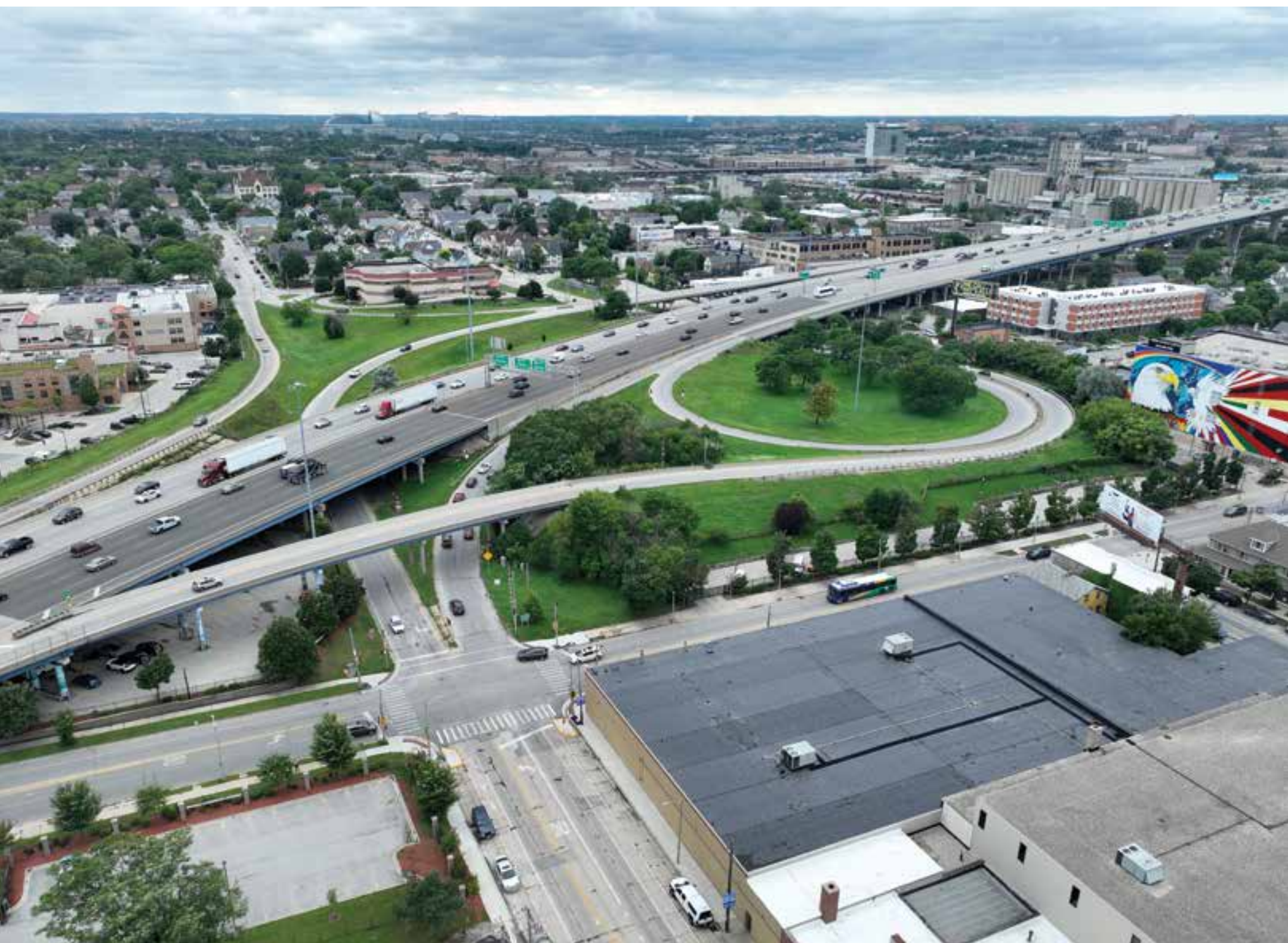
Existing interchange ramps at I-43 at National Avenue Rampas existentes del intercambiador de la I-43 en la avenida National Avenue
