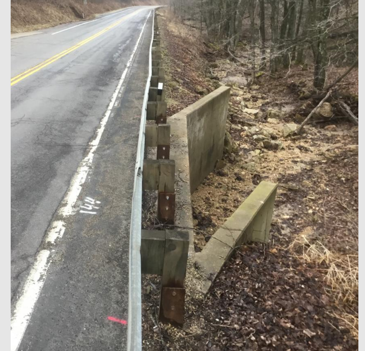
Box Culvert C-62-326–Outlet
