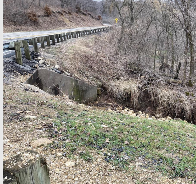
Box Culvert C-62-325–Outlet
