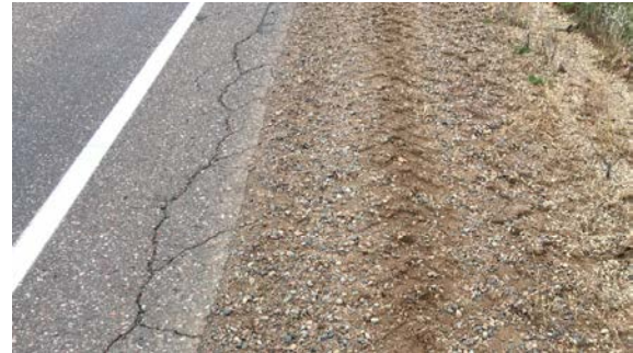
(d) Edge cracking
