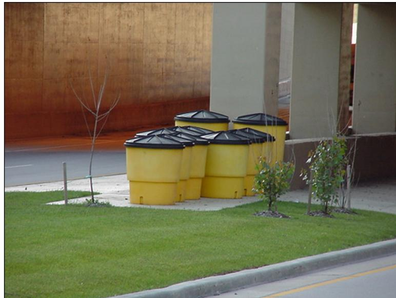
**Figure 2.9.3.3-1:** Impact Attenuator System.
