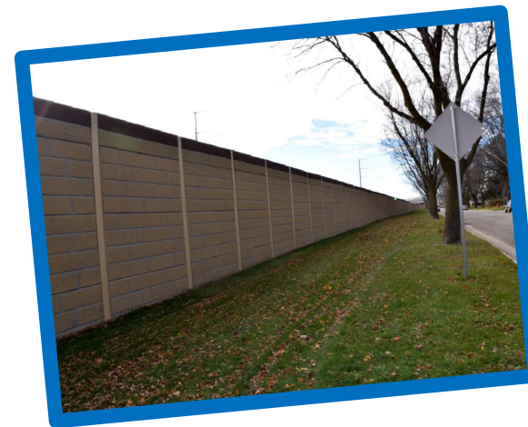
Barrera de ruido en el lado residencial.
